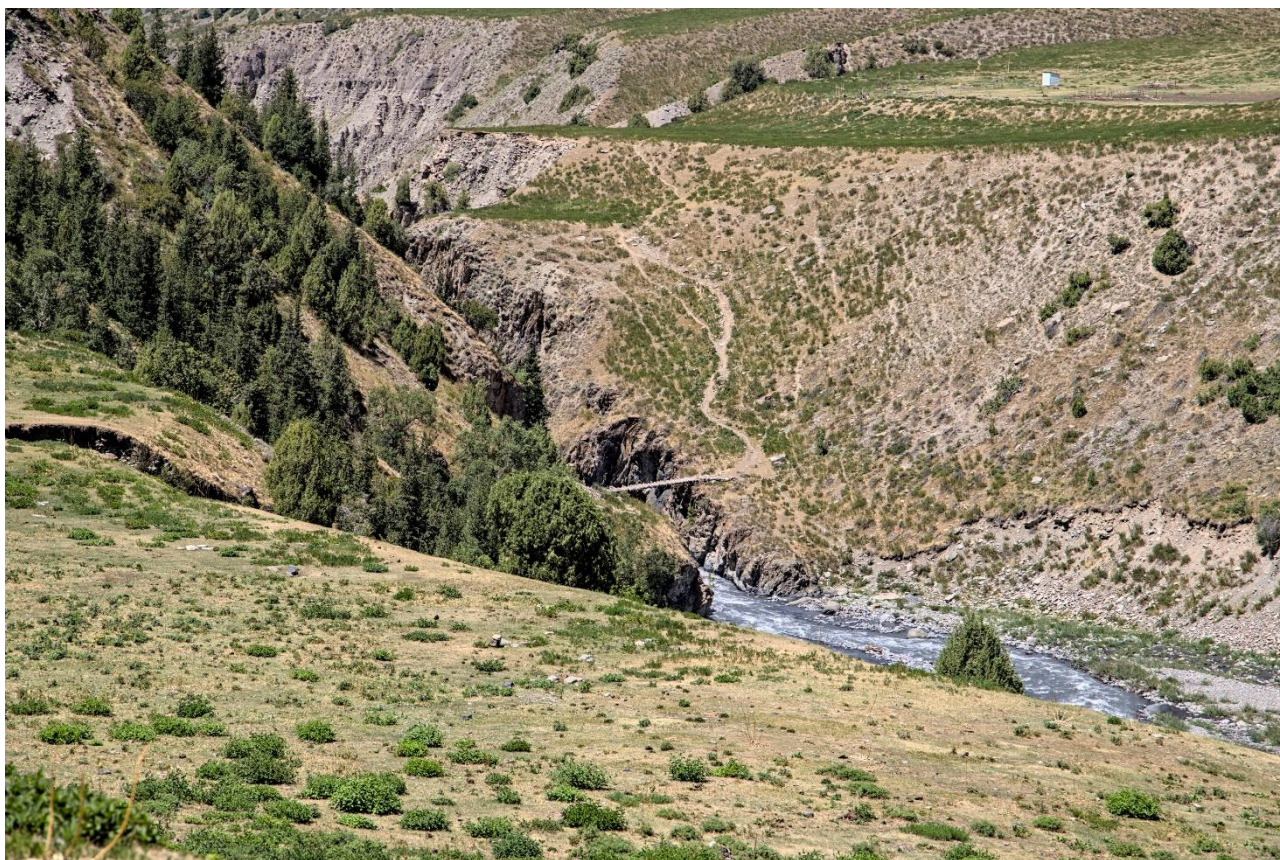
Ещё один мост через Терек.
